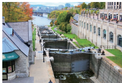
上/およそ2000人の作業員により、6年間で建設されたリドー運河 左下/閘門は今も人の手でウィンチを巻き上げて操作される 右下/建国の歴史を物語る美しい町並みのオタワ
